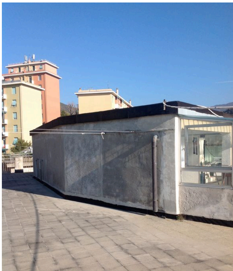
FOTO 29 – TERRAZZO DI COPERTURA
