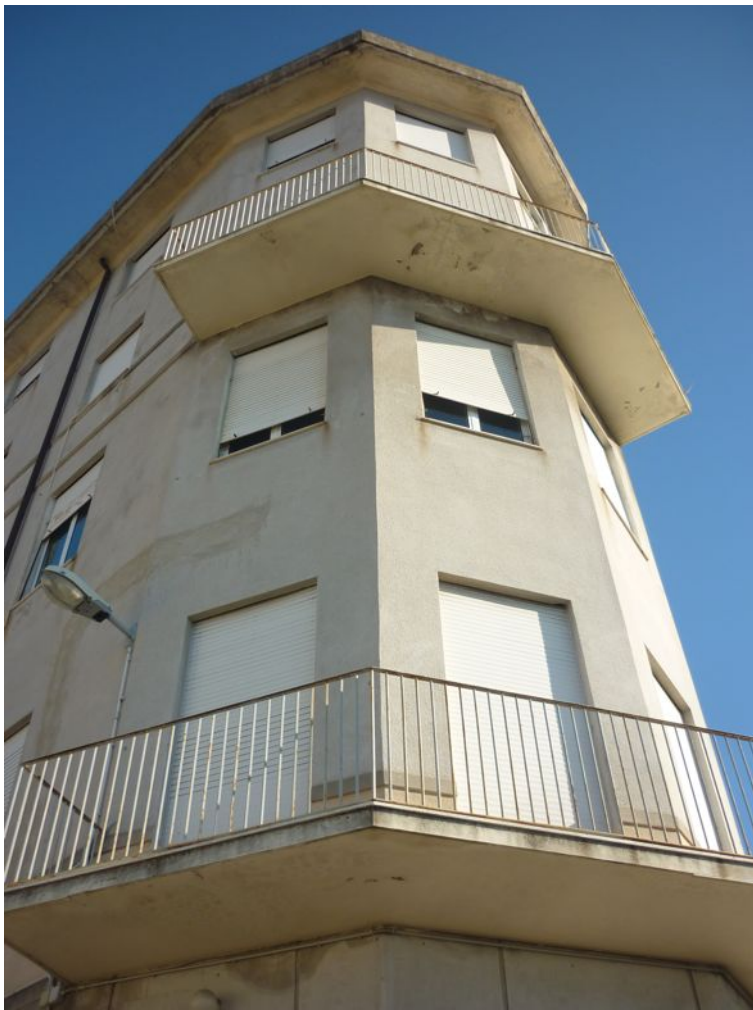
FOTO 23 – ESTERNO FRONTE LATO SUD
