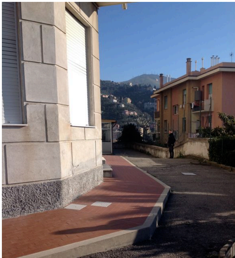
FOTO 26 - AREA ESTERNA FRONTE SUD
