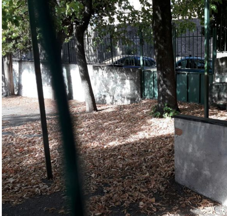
FOTO 19 – CANCELLO CARRABILE AREA RECINTATA A MONTE
