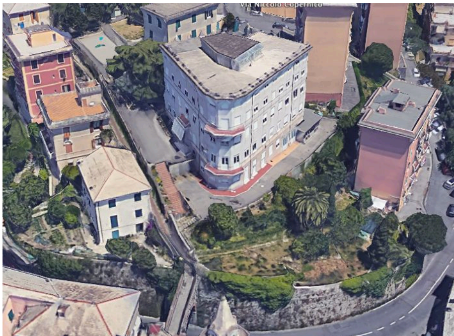
FOTO 02 – VISTA DALL'ALTO LATO SUD
