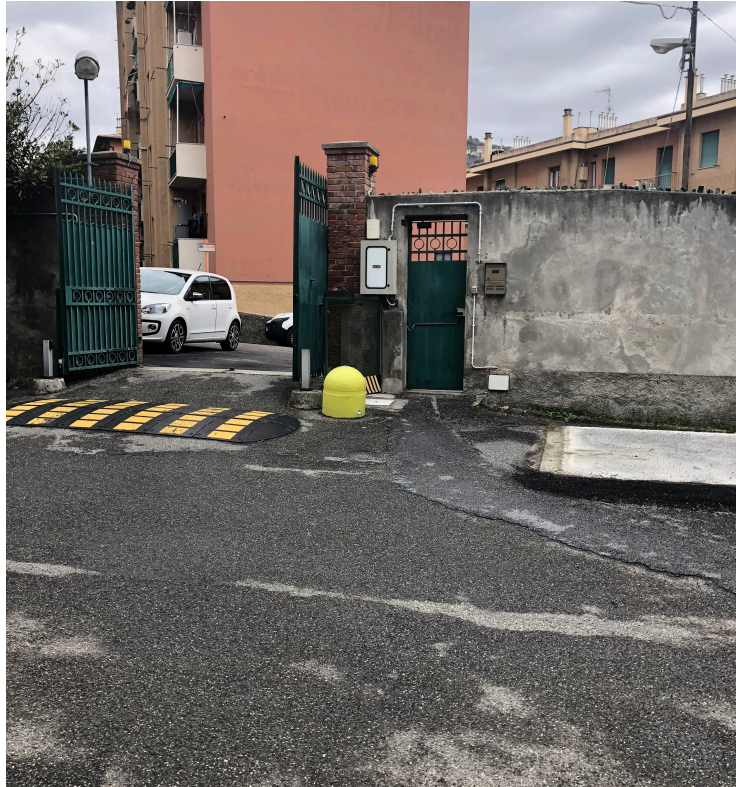
FOTO 15 – INGRESSO CARRABILE VIA COPERNICO
