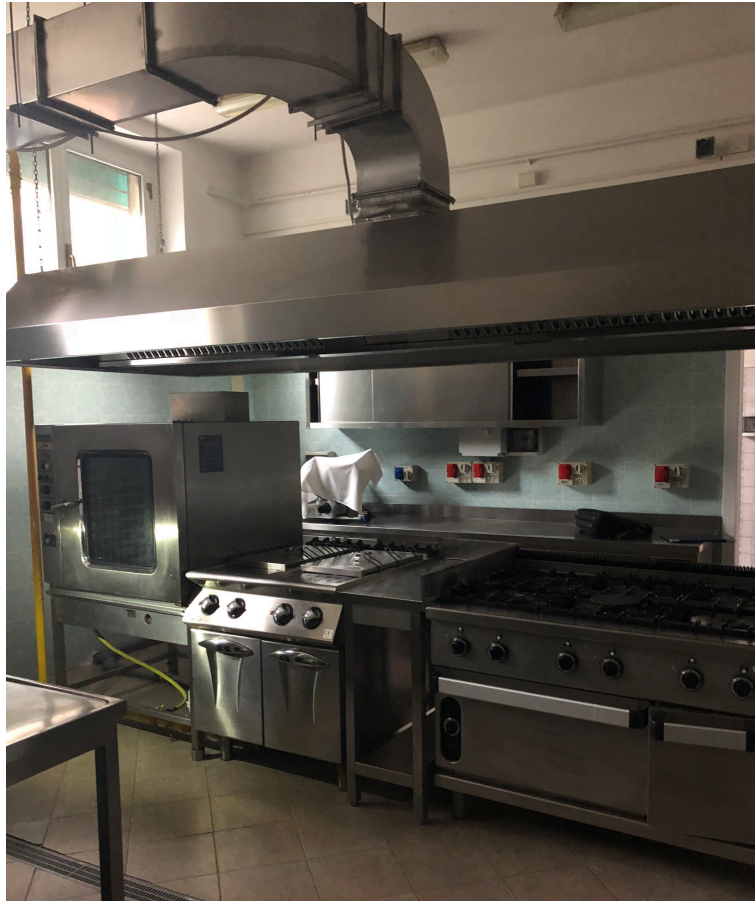
FOTO 37 - LOCALE CUCINA PIANO TERRA
