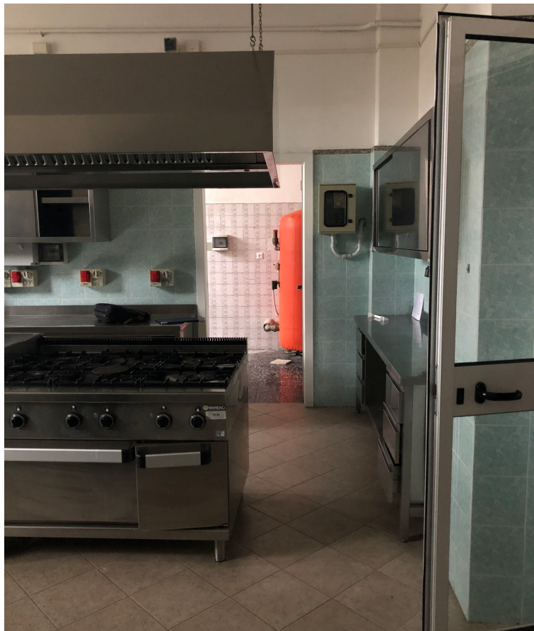
FOTO 38 - LOCALE CUCINA PIANO TERRA
