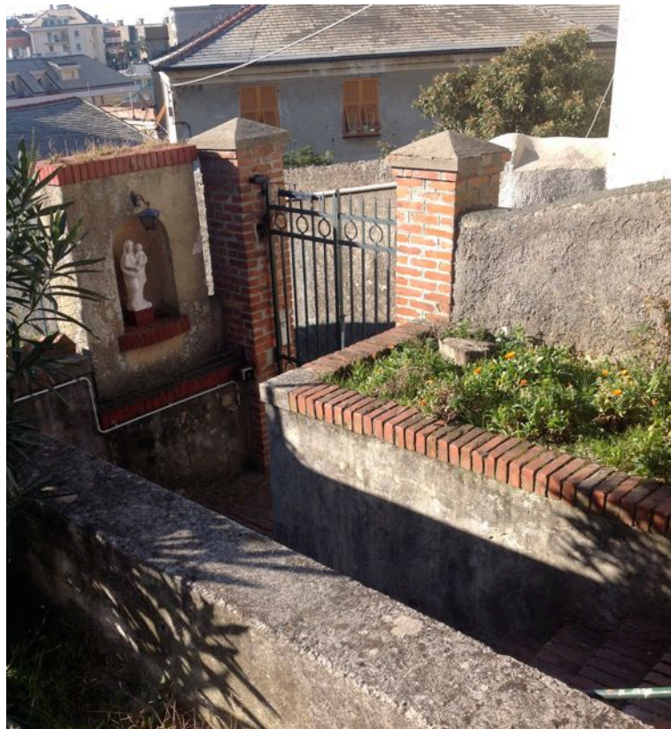
FOTO 22 – CANCELLO INGRESSO PEDONALE VIA DEL SOLE
