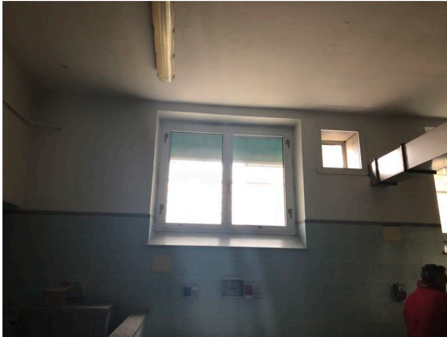
FOTO 39 – LOCALE CUCINA PIANO TERRA
