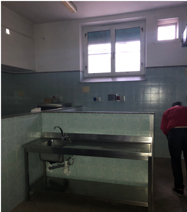
FOTO 36 – LOCALE CUCINA PIANO TERRA
