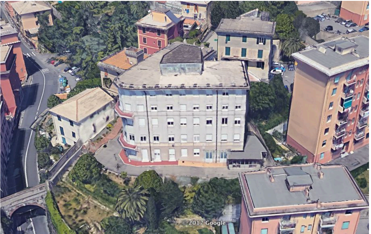
FOTO 03 – VISTA DALL'ALTO LATO EST
