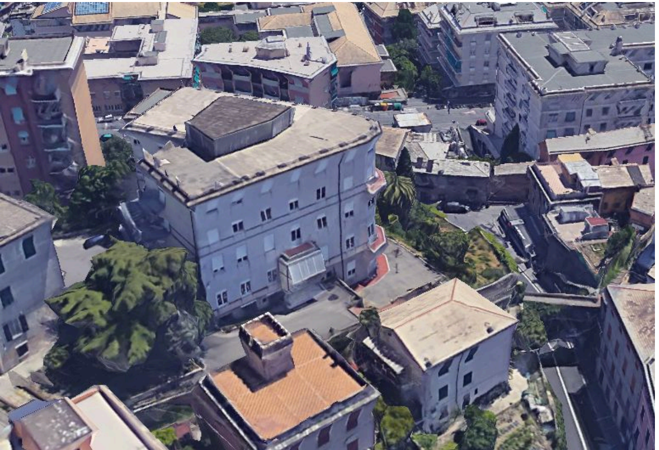
FOTO 06 – VISTA DALL'ALTO LATO OVEST
