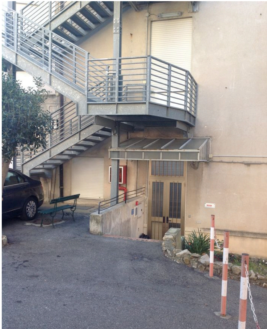
FOTO 13 – INGRESSO LATO NORD
