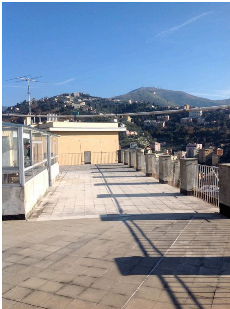
FOTO 31 - TERRAZZO DI COPERTURA
