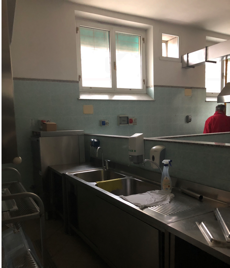
FOTO 35 – LOCALE CUCINA PIANO TERRA
