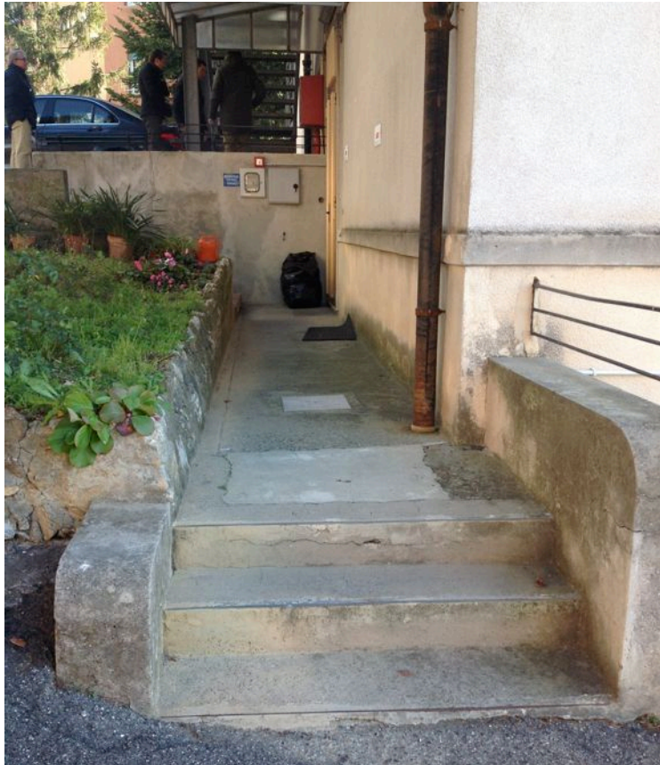
FOTO 11 – CAMMINAMENTO INGRESSO LATO NORD
