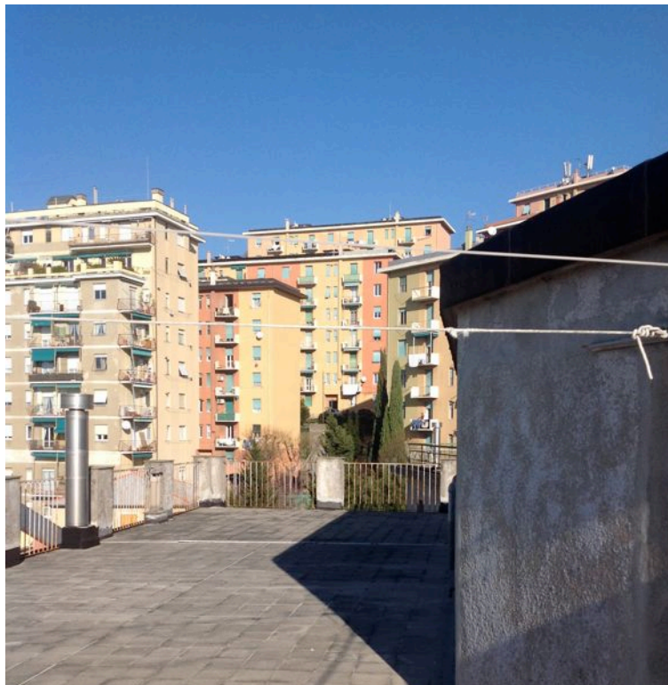
FOTO 28 – TERRAZZO DI COPERTURA
